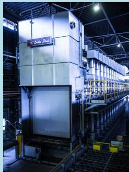
当社星崎工場稼働するプレミアムSTC®炉
